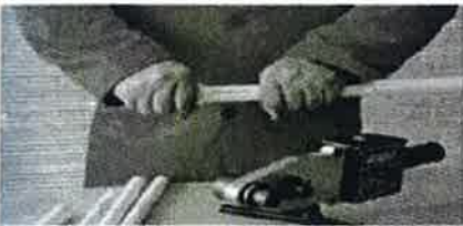
Rohre und Fittings werden zusammen- geschweißt.
