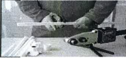
Abschneiden des Rohres.
